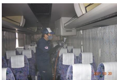
光触媒施工の様子
